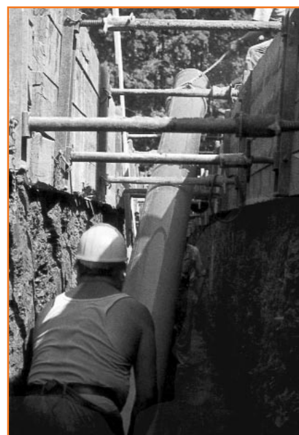
Az M-Wavin KG csatornacső a dúcolások között is könnyen fektethető
