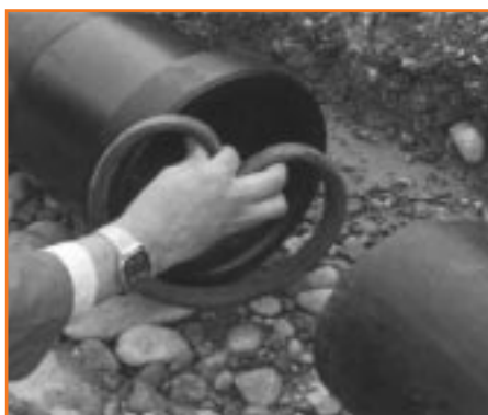
Gumigyűrű behelyezése hosszútokos PE csatornacsőbe
