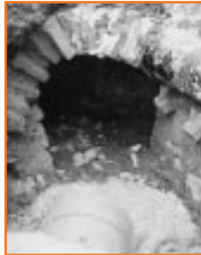
1. ábra: Betömedékelt falazott bekötővezeték a tisztítóaknában (Székesfehérvár)
