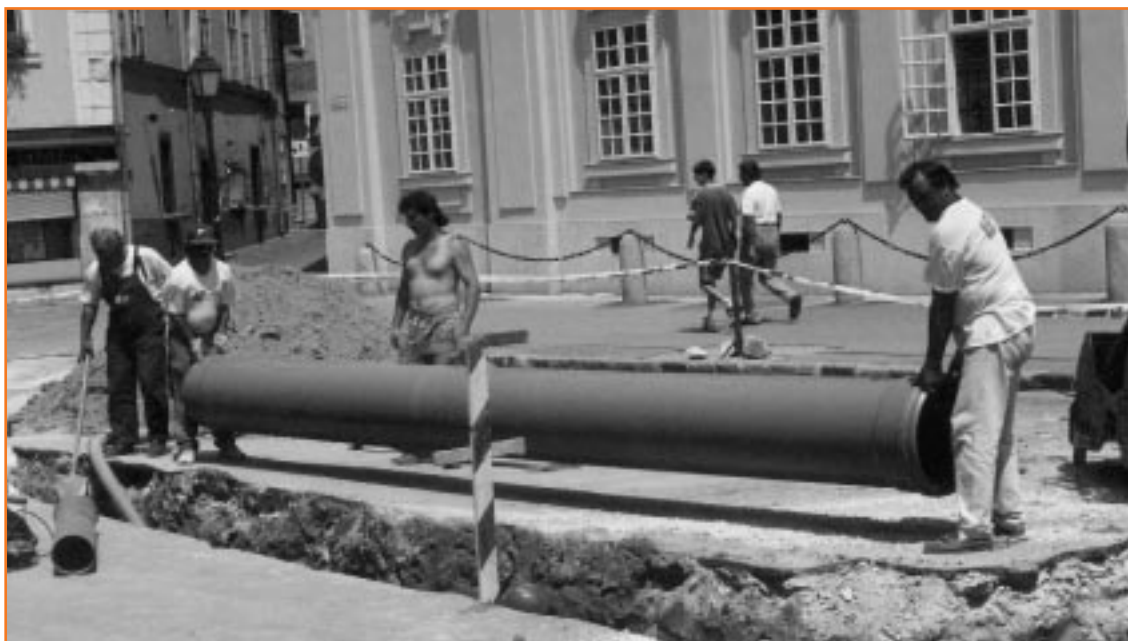
A PVC csatornacső kézzel is könnyen mozgatható (Székesfehérvár)
